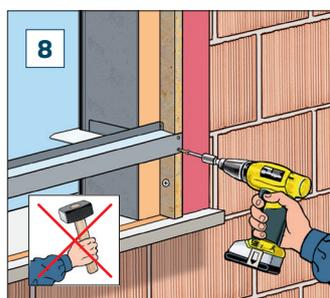
8. Rimuovere le dime distanziatrici ed eventuali elementi di controventatura applicati al controlaio utilizzando un avvitatore evitando di demolirli con martelli o mazze.
