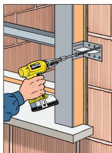
4. Fissare il controtelaio alla parete aprendo e murando le zanche in dotazione o, come richiesto nei moderni sistemi di posa, utilizzando **turboviti** e le **staffe** in dotazione da tassellare alla parete (rispettare le istruzioni di installazione del produttore di turboviti e tasselli).
