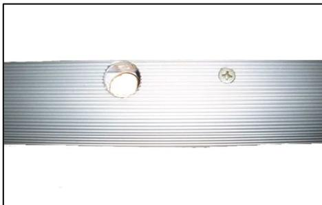
A questo punto se siamo in presenza di battuta "tipo 1" con traversa in alluminio, applicare una congrua riga di silicone sotto la traversa, prima di forarla nella posizione riscontrata ed il pavimento sottostante in corrispondenza della "macchia" con una punta diametro 20mm . Si sottolinea che il foro sul pavimento è fondamentale per la resistenza meccanica dell'assieme, verificare la solidità e
